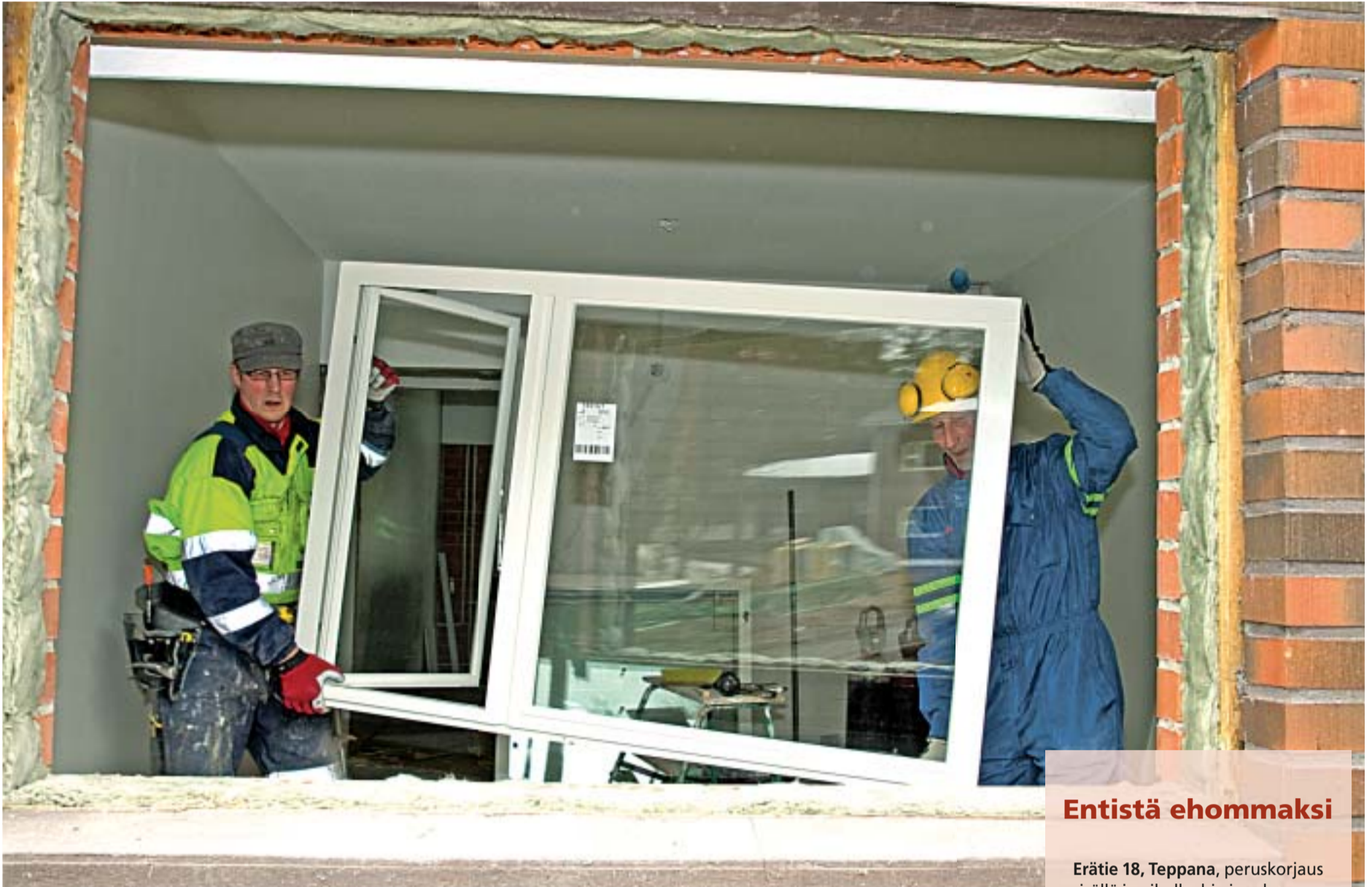
Rakennusmiehet Kari Heikkinen (vas.) ja Pentti Komulainen asentavat uutta ikkunaa Ketunpolun opiskelija-asuntoon.
