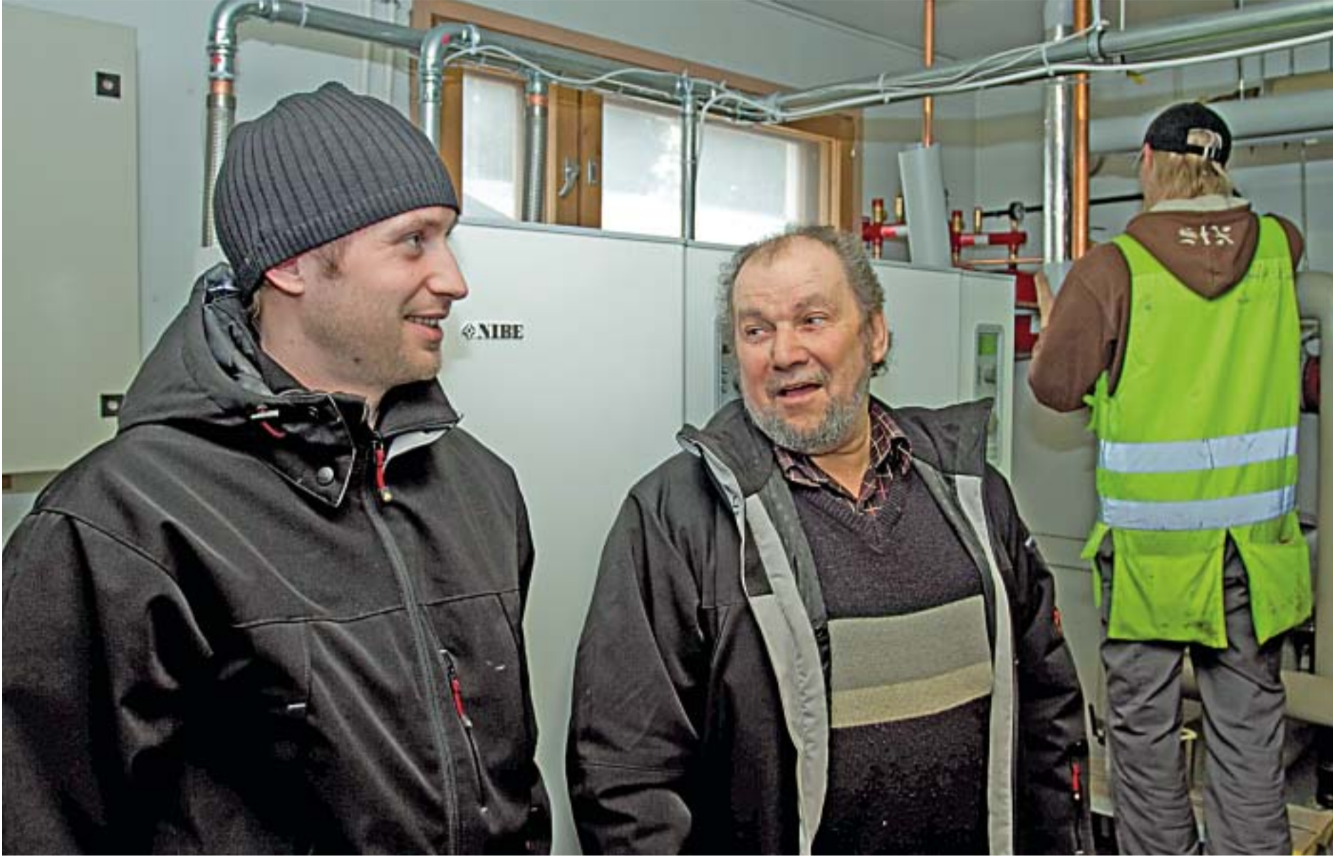
Frank Snellman (vas) ja Jörgen Grankulla Tec Heat Oy:sta ohjasivat lämpöpumppujen asentamista Maamiehentien lämmönjakohuoneeseen.
