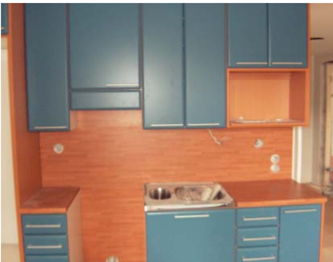
Opiskelija-asuntojen keittiöihin asennetaan uudenaikaisia kalusteita ja varusteita.
